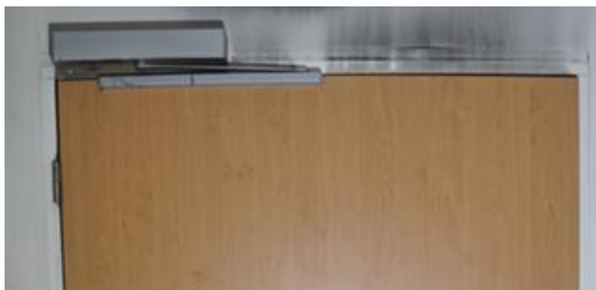
Figuur 5.6 Roetaanslag als indicator voor rookverspreiding via de naad aan de bovenzijde van de deur
