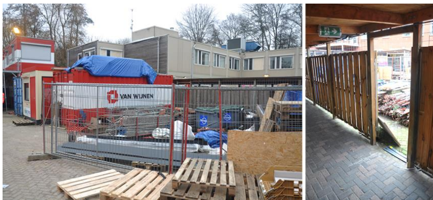
Figuur 6.4 Geblokkeerde vluchtroute achter de nooduitgang van de overdekte looproute
