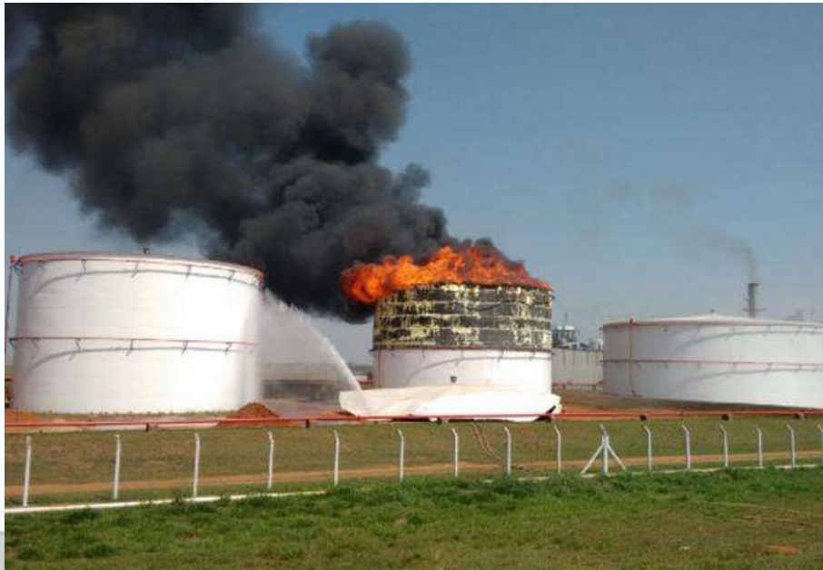
Paraiso, Brazilië, 11 september 2016, ethanoltank (Ø 23 meter)
