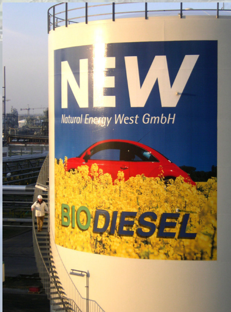
Opslagtank voor biodiesel
