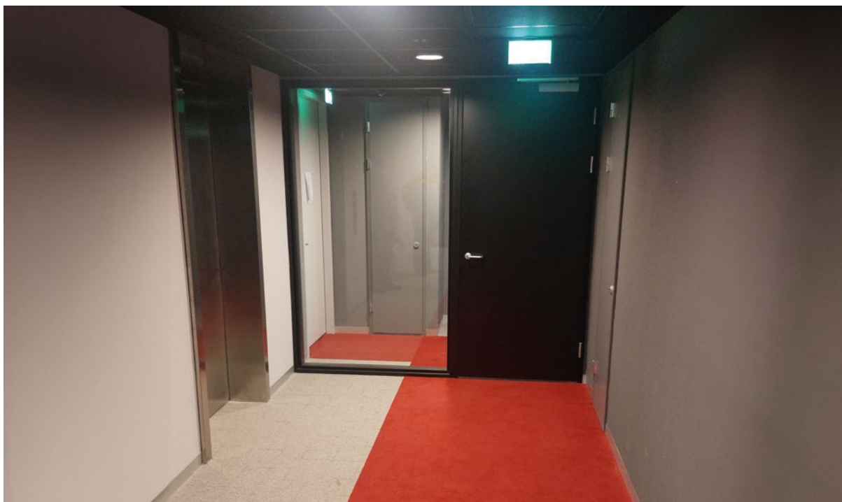
Foto 2: De compartimentering gezien vanuit de lifthal.
